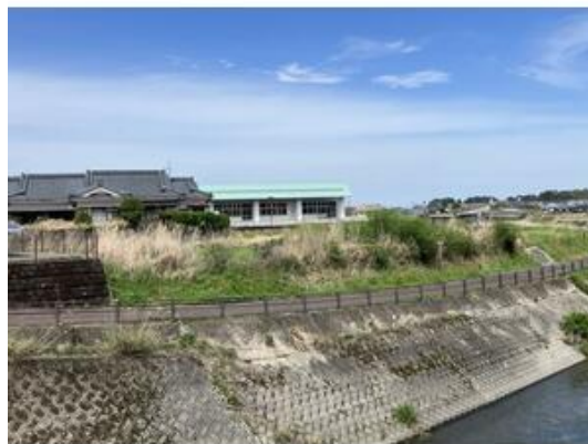
いちのさか橋から見た現地
