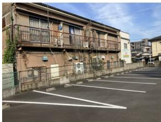
南側隣地から
