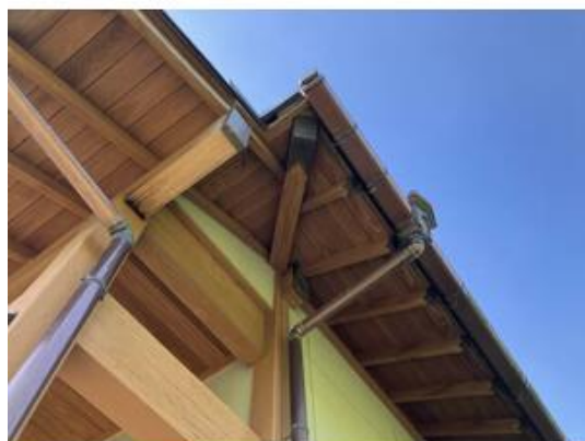
縦樋・横樋共に銅製で趣があります。
