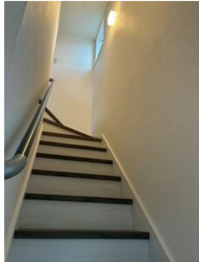
2階から屋上への階段
