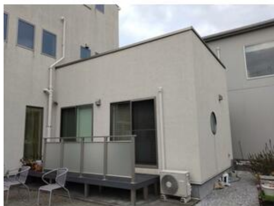
和室部分外観・樹脂デッキ
